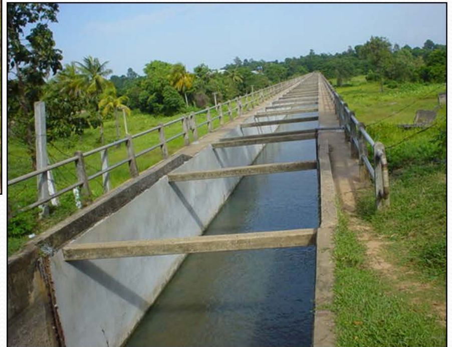
สะพานน้ำ (Elevated Flume)
