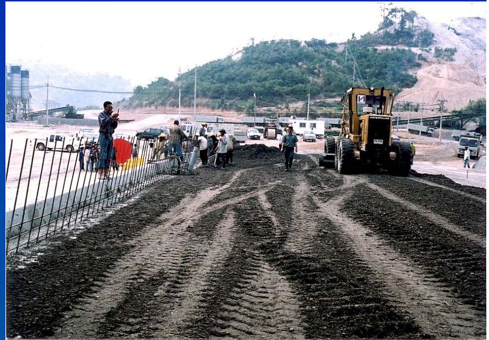
การไ้ระดับ RCC โดย Motor Grader ก่อนการเดทับ
