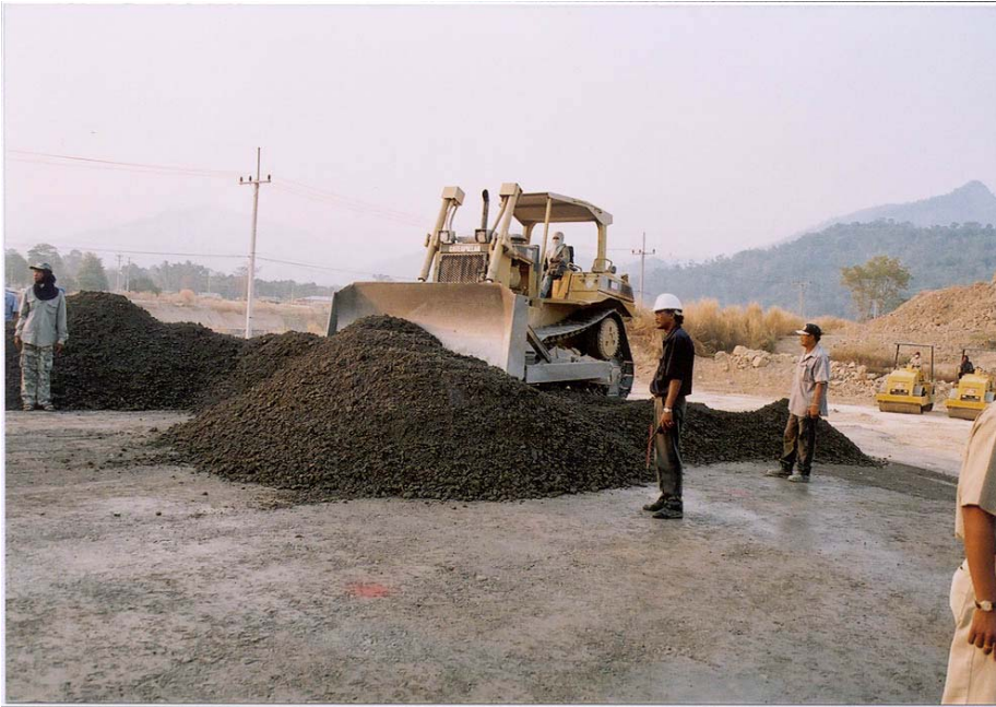
การล้มกอง RCC โดย Tractor ขนาด D6
