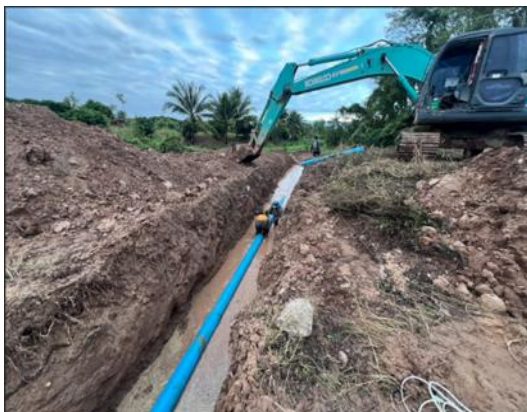
กำลังปรับปรุงท่อระบายน้ำลงลำน้ำเดิม (River Outlet)
