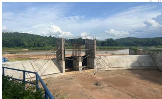
ขณะดำเนินการงานก่อสร้าง
