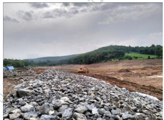
ปรับหินทับแผ่นใยสังเคราะห์
