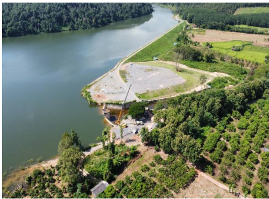
ขณะดำเนินการงานก่อสร้าง
