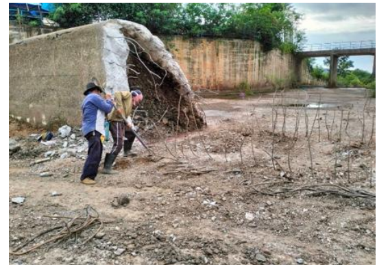
ขณะดำเนินการงานก่อสร้าง
