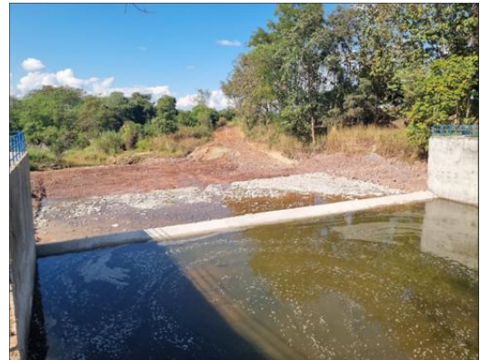
งานซ่อม Chute Block และ End Sill
