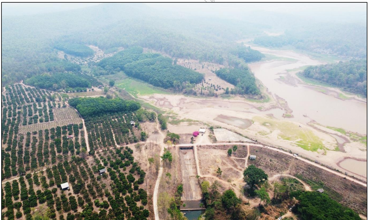
ภาพที่ 4 ภาพบริเวณอาคารระบายน้ำล้นอ่างเก็บน้ำห้วยน้ำแวนก่อนดำเนินการก่อสร้าง
