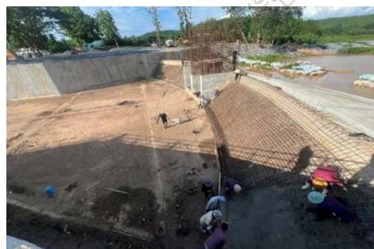
ขณะดำเนินการงานก่อสร้าง
