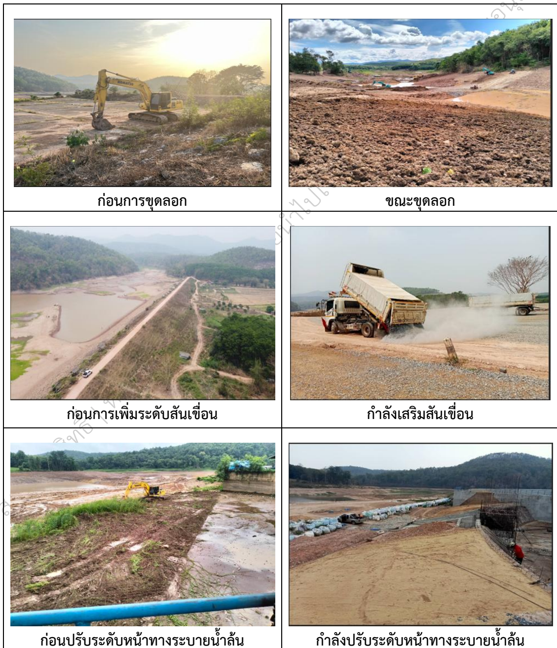
ภาพที่ 21 การขุดลอกและปรับปรุงตัวเขื่อนและบริเวณทางระบายน้ำล้น
