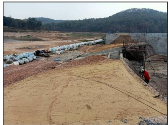
กำลังปรับระดับหน้าทางระบายน้ำล้น
