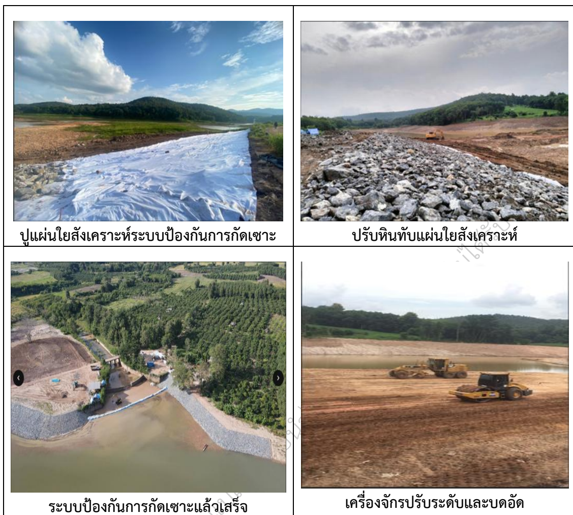
ภาพที่ 19 การปรับปรุงอาคารประกอบ ตัวเขื่อน ระบบป้องกันการกัดเซาะ และการใช้ประโยชน์วัสดุขุดลอก
