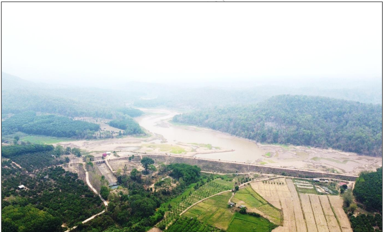
ภาพที่ 3 ภาพอ่างเก็บน้ำห้วยน้ำแวนก่อนดำเนินการก่อสร้าง
