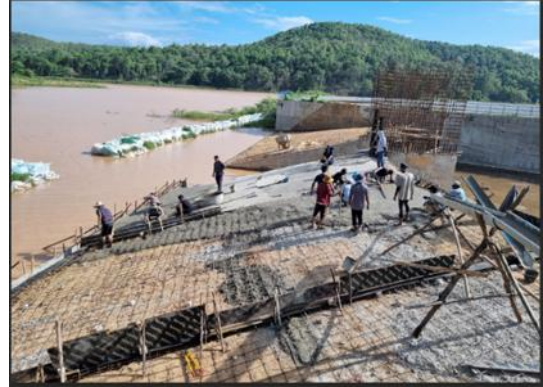
กำลังเทพื้นคอนกรีตด้านหน้าทางระบายน้ำล้น
