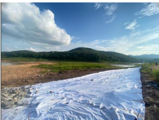
ปูแผ่นใยสังเคราะห์ระบบป้องกันการกัดเซาะ
