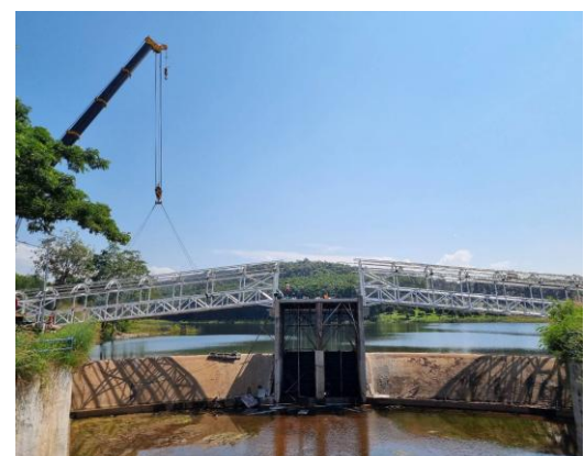
ขณะดำเนินการงานก่อสร้าง
