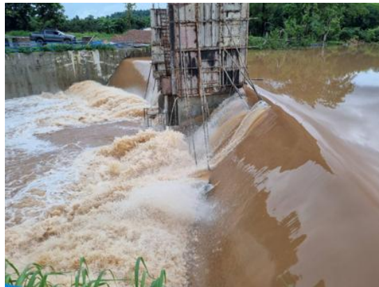
พื้นที่ขณะเกิดอุทกภัยน้ำท่วมไหลหลาก ในพื้นที่โครงการฯ
