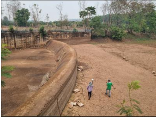
ก่อนเทพื้นคอนกรีตด้านหน้าทางระบายน้ำล้น
