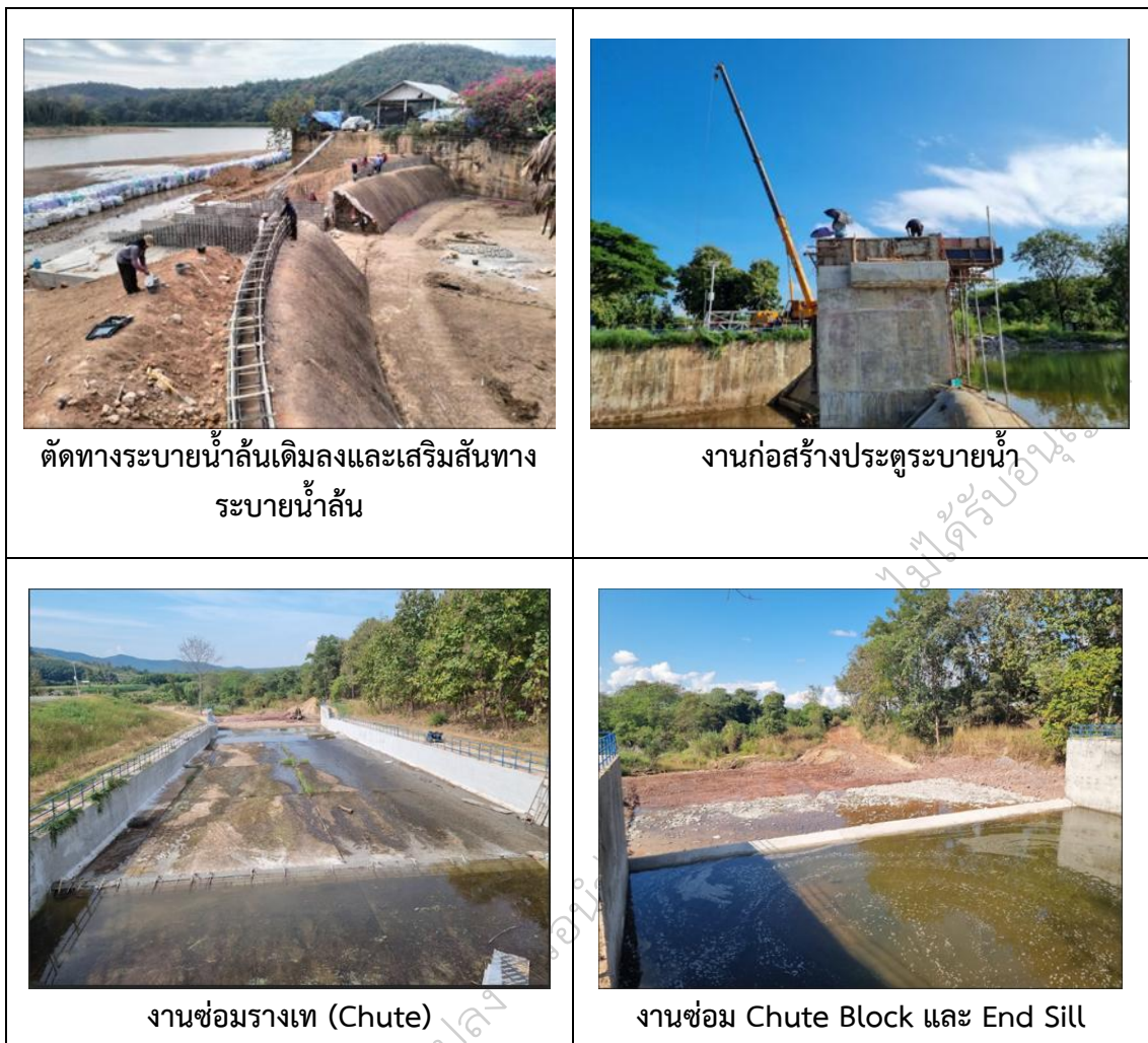
ภาพที่ 22 การก่อสร้างและตัดแปลงอาคารระบายน้ำล้นและอาคารประกอบ
