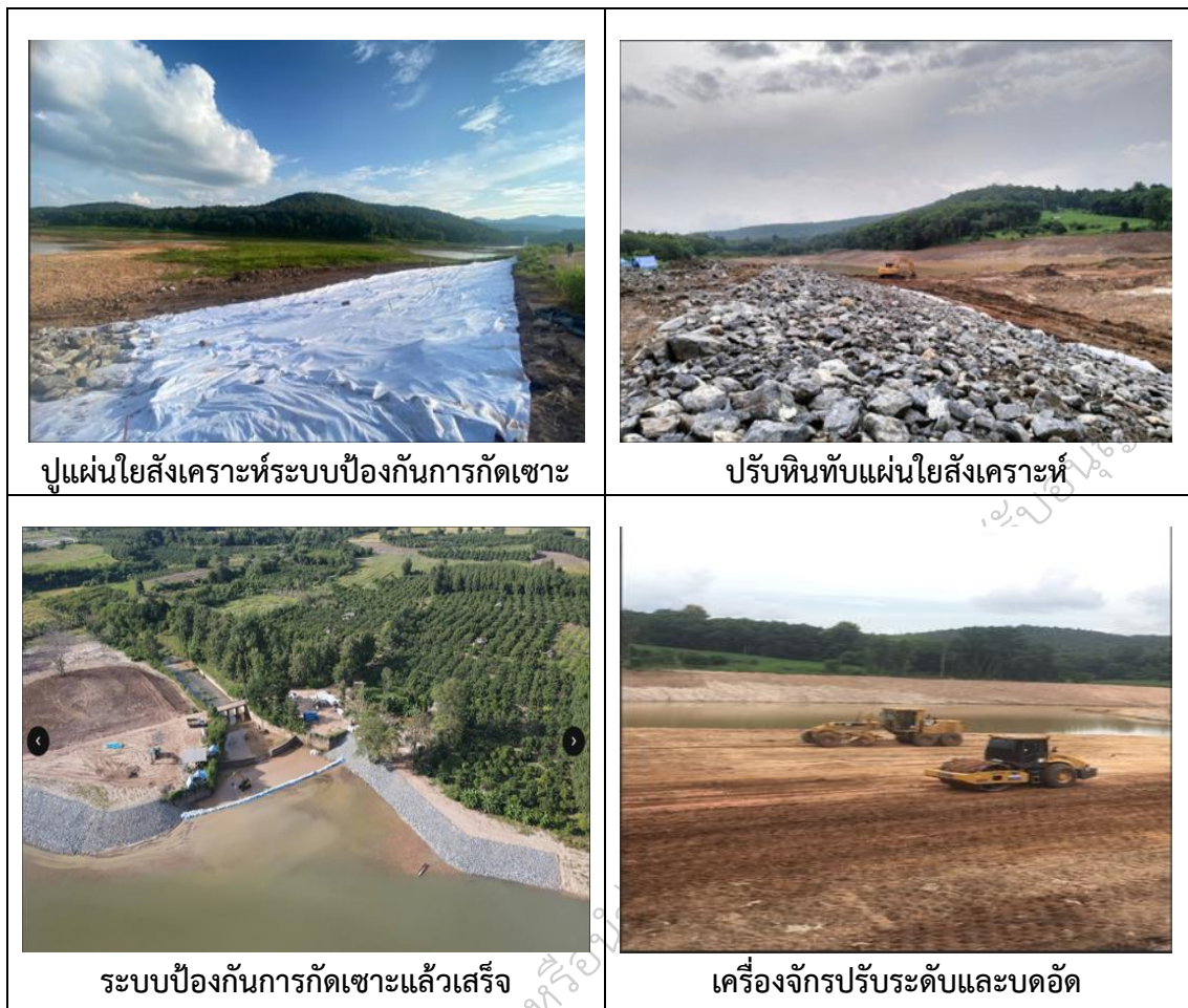
ภาพที่ 23 การบดอัดและการก่อสร้างระบบป้องกันการกัดเซาะ
