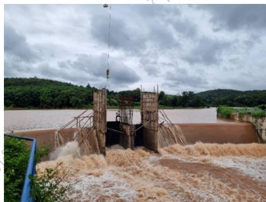
พื้นที่ขณะเกิดอุทกภัยน้ำท่วมไหลหลาก ในพื้นที่โครงการฯ
