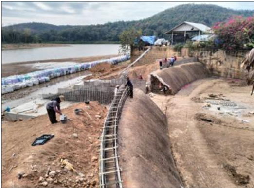
ตัดทางระบายน้ำล้นเดิมลงและเสริมสันทาง ระบายน้ำล้น
