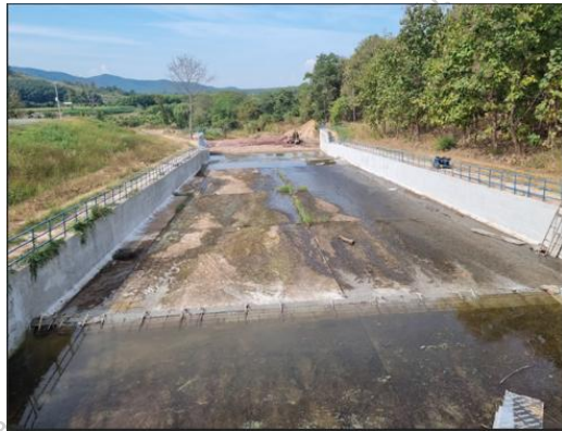
งานซ่อมรางเท (Chute)
