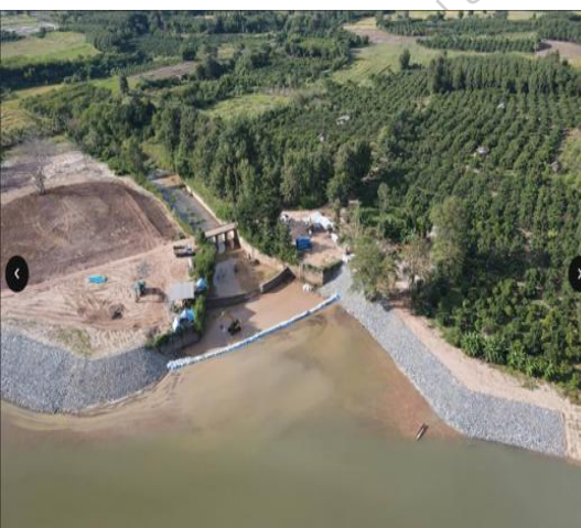
ระบบป้องกันการกัดเซาะแล้วเสร็จ
