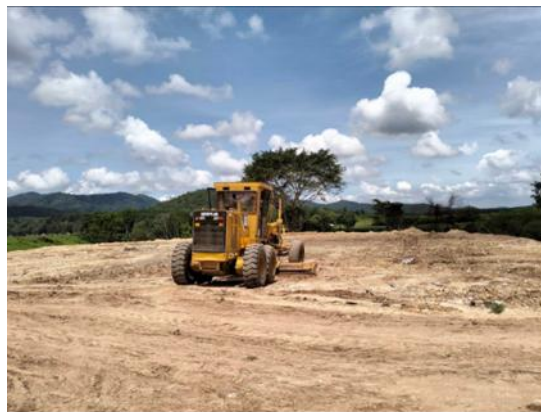
กำลังถมดินปรับพื้นที่ลานอเนกประสงค์
