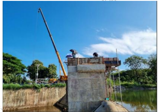
งานก่อสร้างประตูระบายน้ำ
