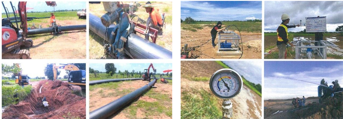
รูปที่ 4-5 การตรวจสอบขนาดความหนาท่อส่งน้ำ การใช้เครื่อง Data Logger เก็บข้อมูลในการเชื่อมต่อ HDPE และการตรวจสอบและวัดความดันน้ำในเส้นท่อ และการทดลองเปิดใช้น้ำ
