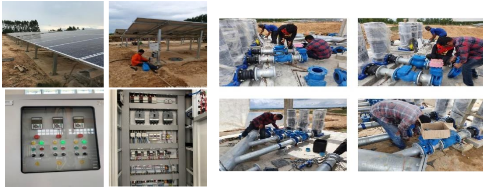
รูปที่ 4-7 งานระบบโซลาร์เซลล์ การเดินสายเข้าตู้ควบคุมและ Inverter ในโครงการ และการติดตั้ง Check Valve, Butterfly Valve, Surge Anticipating Valve และ Air Valve
