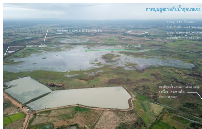
รูปที่ 3.1-1 ภาพถ่ายมุมสูงแสดงองค์ประกอบของอ่างเก็บน้ำกุดนาแซง
