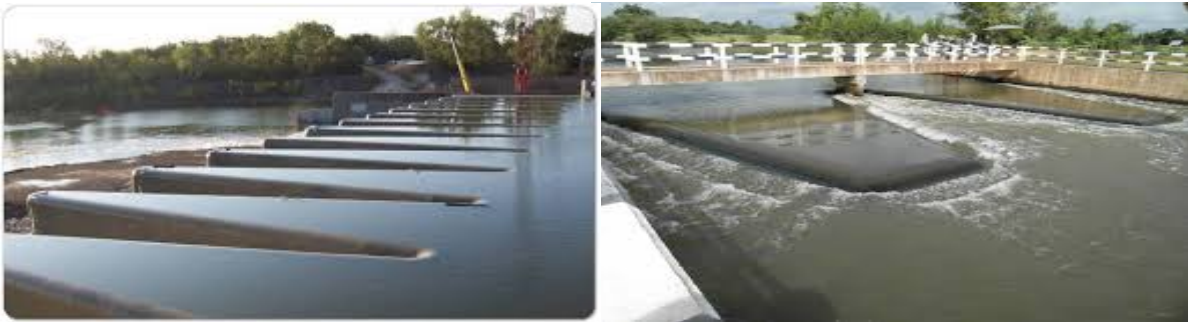
ฝายน้ำล้นแบบสันทัยก(Labyrinth Weir)
