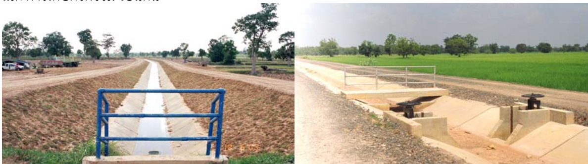
ระบบกระจายน้ำ
