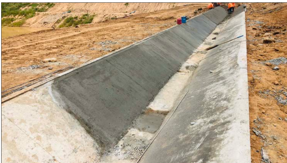
รูปที่ 2 คลองดาดคอนกรีต
