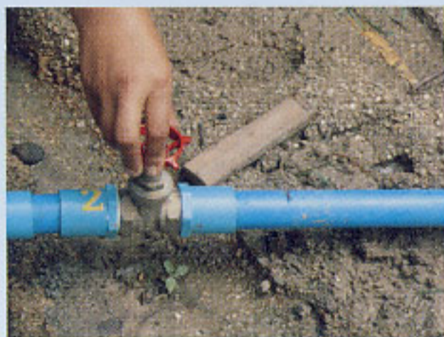
๗) เปิดประตูน้ำหมายเลข ๒ รอสักครู่ น้ำจะเพิ่มขึ้น แล้วเริ่มทำการกรอง
