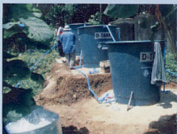
๙) ประกอบถังเข้ากับท่อน้ำ และประตุน้ำล่างทรายกรอง
