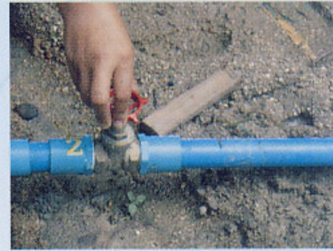
๔) หากน้ำเต็มขวดก่อน ๕๕ วินาที ให้หรีประตูน้ำหมายเลข ๑ หากน้ำเต็มขวดหลัง ๕๕ วินาที ให้เปิดประตูน้ำหมายเลข ๑ ให้กว้างขึ้นตวงจนได้เต็มขวดภายในเวลา ๕๕ วินาที เสร็จแล้วปิดก๊อกน้ำหมายเลข ๑ เปิดประตูน้ำหมายเลข ๒
