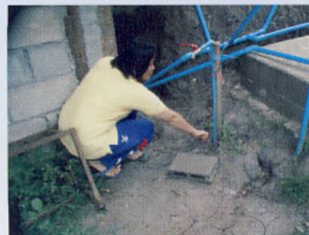
๑๐) ปิดก๊อกน้ำหมายเลข ๓ เปิดก๊อก หมายเลข ๒ น้ำไหลลงถังน้ำดื่ม
