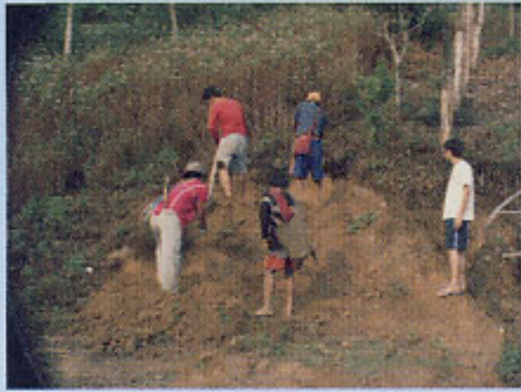
๑) เตรียมพื้นที่วางถังตกตะกอน ถังกรองใบที่ ๑ และ ๒ ให้แต่ละใบมีความสูงแตกต่างกันไม่น้อยกว่า ๓๐ ซม.
