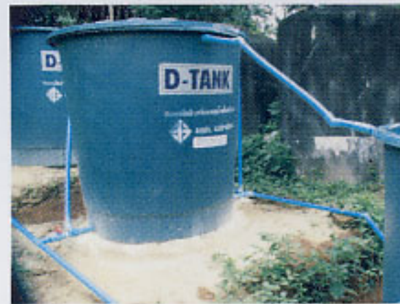
๘) ประกอบท่อน้ำจากถังกรองใบที่ ๑ เข้า ถังกรองใบที่ ๒ และประกอบท่อกระจายน้ำ เข้าถังกรองใบที่ ๒
