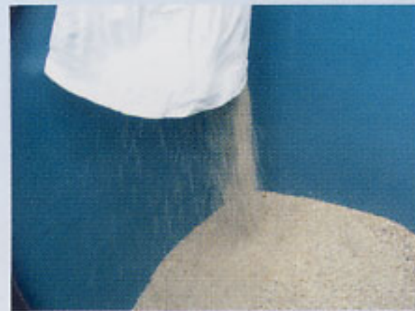
๕) ใส่กรวดขนาด ๒"-๒ ๑/๒", ๑ ๑/๒"-๑" และ ๑"-๑ ๑/๒" อย่างละ ๐.๑ ม. และทรายกรอง ขนาด ๐.๓๐ - ๐.๔๕ มม. จำนวน ๑ ม. ตาม ลำดับในถังกรองใบที่ ๑
