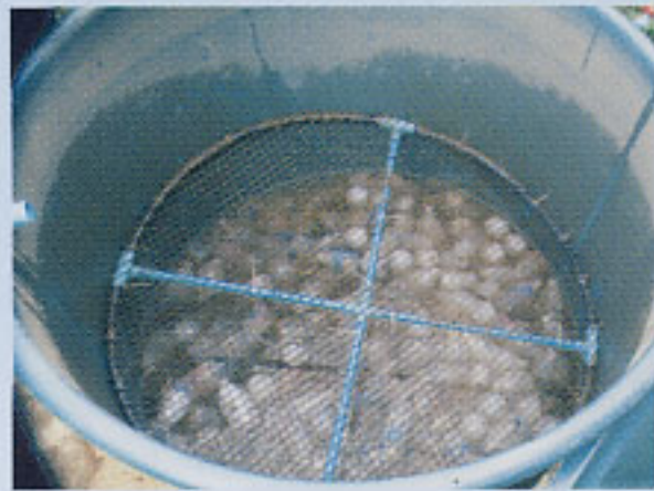
๓) ติดตั้งตะแกรงรองตัวกลางขวดน้ำและไส้ ขวดน้ำ และตะแกรงตัวบนในถังตกตะกอน
