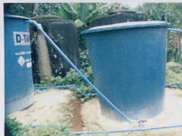
๗) ประกอบท่อน้ำจากถังตกตะกอนเข้า ถังกรองใบที่ ๑
