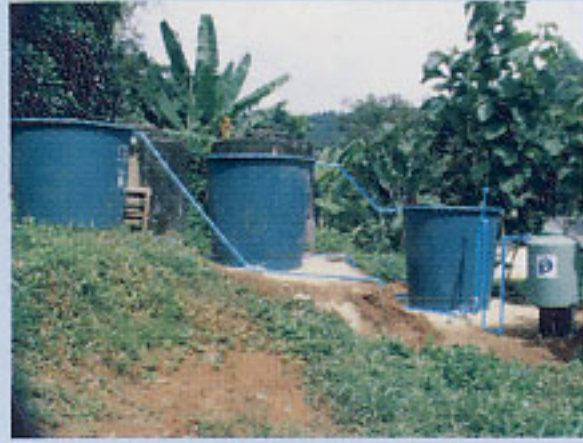
๒) ติดตั้งถังไฟเบอร์กลาสสำหรับถังตกตะกอน ถังกรองใบที่ ๑ และ ๒ โดยวางท่อน้ำเข้า และ ท่อน้ำออกในแนวท่อที่จะต่อลงถึงถัง ๓ เข้าด้วยกัน
