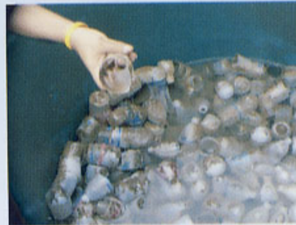
รูปที่ ๓.๑ สภาพถังตกตะกอนที่มีปริมาณตะกอนสะสมตามผนัง และตัวกลางช่วยตกตะกอนที่จะต้องทำความสะอาด
