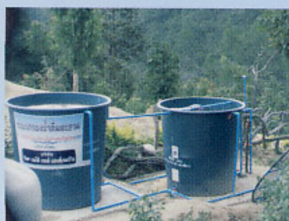
๑๐) ประกอบท่อน้ำล้น ท่อระบายตะกอนและประตุน้ำระบายตะกอน ถังตกตะกอน ถังกรองใบที่ ๑ และ ๒ เข้ากับท่อน้ำทั้งหมด
