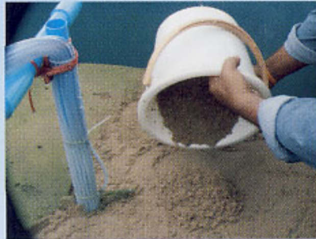
๖) ใส่ทรายสำรองที่ยังไม่เคยใช้งานมาก่อน ลงบนหน้าทรายกรองให้ทั่วหน้าทรายกรอง และหนาเท่าเดิมเกลี่ยให้สม่ำเสมอ
