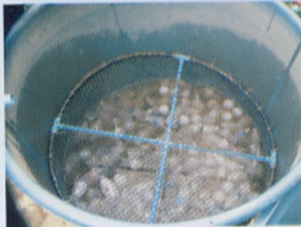
รูปที่ ๓.๑ สภาพถังตกตะกอนที่มีปริมาณตะกอนสะสมตามผนัง และตัวกลางช่วยตกตะกอนที่จะต้องทำความสะอาด
