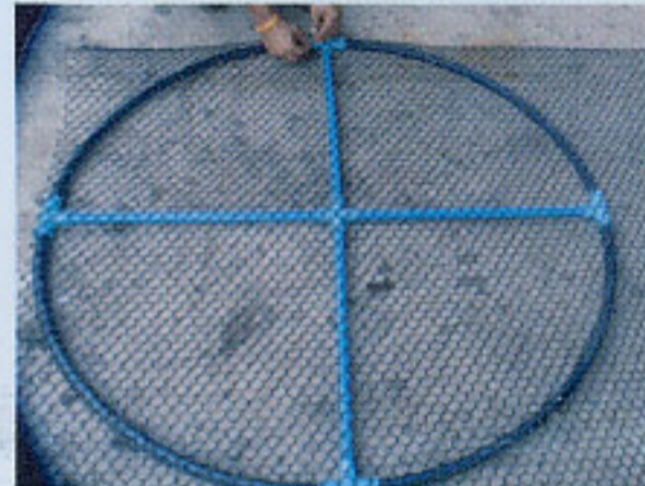
๔) นำตาข่ายขนาด ๓/๔" มาปูด้านบนแล้ว ใช้เคเบิลไทร์ผูกให้ติดแน่นกับโครงตะแกรง
