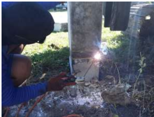
รูปที่ 8 การเชื่อมต่อเสาเข็ม โดยวิธีเชื่อมด้วยไฟฟ้า
