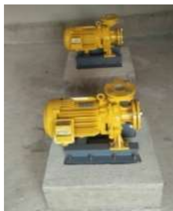
รูปที่ 74 งานแท่นเครื่อง คสล. สำหรับติดตั้งเครื่องสูบน้ำฝังเหล็กสำหรับยึดกับแท่นเครื่อง
