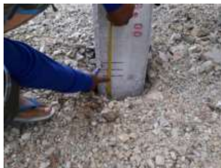
รูปที่ 6 การเช็ค BLOW COUNT การตอกเสาเข็ม
