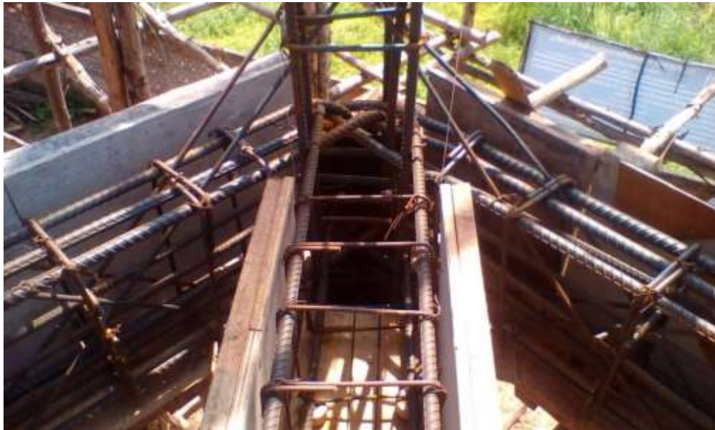
รูปที่ 67 งานเข้าแบบ ผูกเหล็ก เสาคาน หอถังสูง
