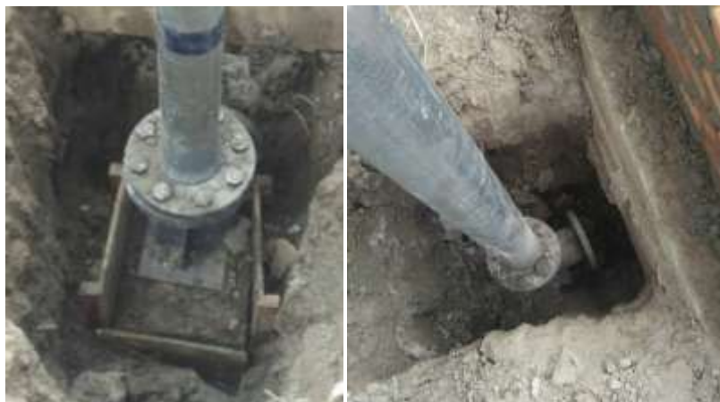
รูปที่ 79 งานท่อจ่ายน้ำหอดังสูงและข้องอขึ้นเปิด
