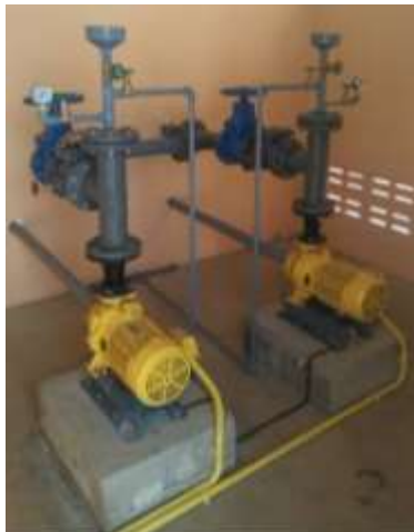
รูปที่ 52 การตรวจสอบปริมาณการสูบน้ำของเครื่องสูบน้ำหอยโข่ง
