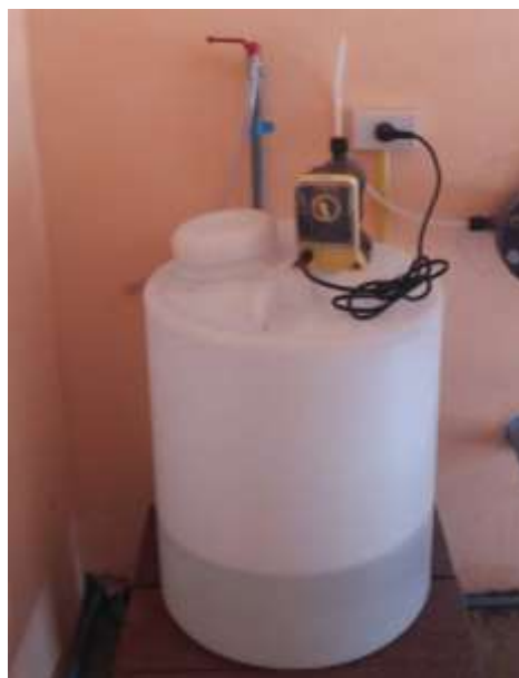
รูปที่ 55 เครื่องจ่ายสารละลายคลอรีนถึงใส่สารละลายคลอรีน
