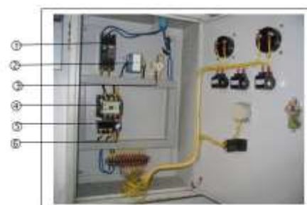
ลักษณะภายในตู้ควบคุม เครื่องสูบน้ำ (แบบหอยโข่ง)
