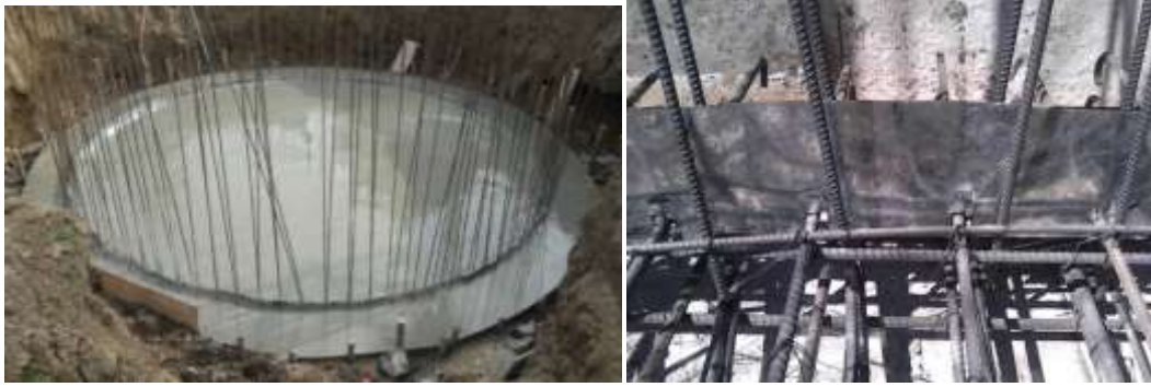
รูปที่ 69 งานเทคอนกรีตฐานรากโครงสร้างถังเก็บน้ำติดตั้งแผ่นสังกะสีกันซึมช่วงรอยต่อคอนกรีต
