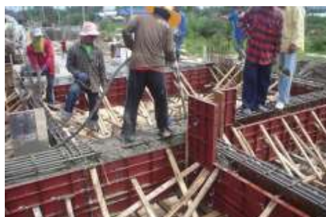
รูปที่ 19 การเทและต้องกระตุ้นให้คอนกรีตด้วยเครื่องสั่น (Vibrator)
