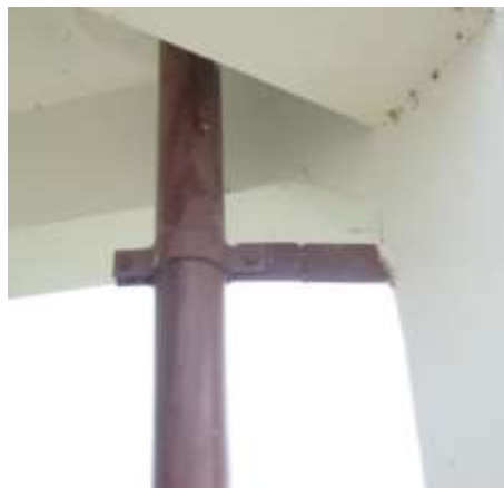
รูปที่ 68 งานฝังเหล็กหางปลา ในคานทุกชั้น สำหรับยึดท่อขึ้นหอถังสูง
