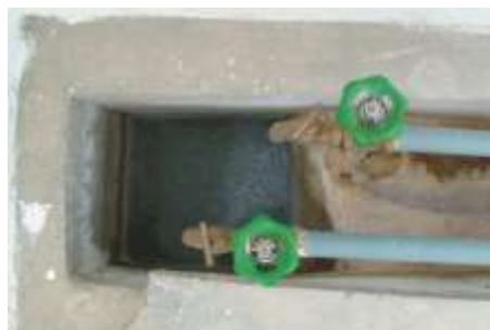
รูปที่ 76 จุดที่ผสมสารละลายสารส้ม และปูนขาว ไฮดรอลิคจัม (HYDRAULIC JUMP)
