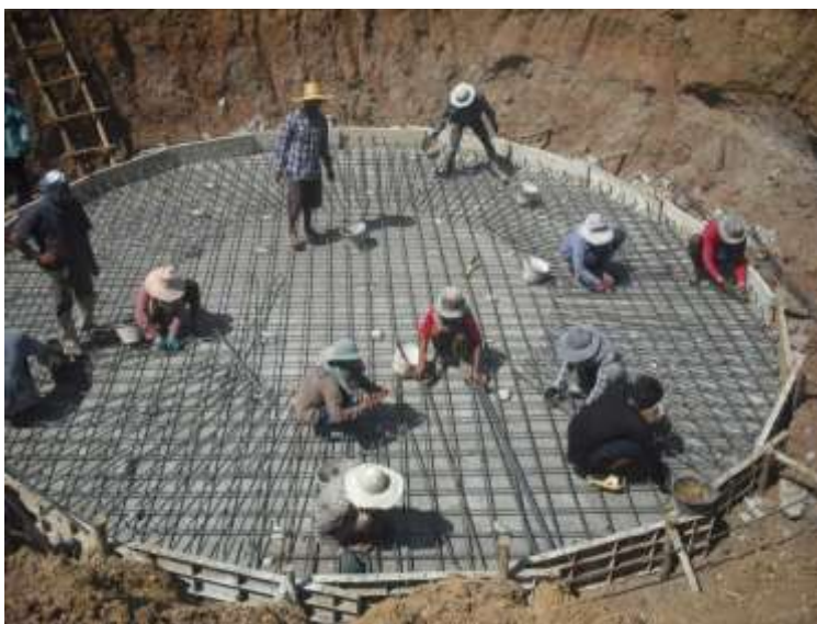
รูปที่ 25 การวางเหล็กเสริมฐานรากถึงน้ำใส
