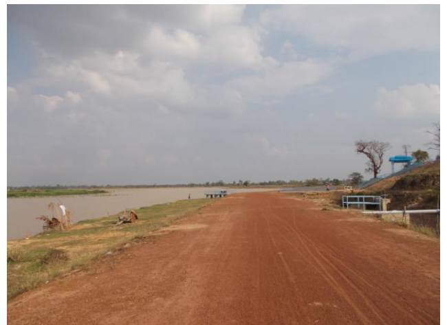
ถนนลูกรังบดอัดแน่นรอบโครงการ
