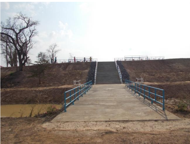
บันไดคอนกรีตเสริมเหล็ก(คสล.)
