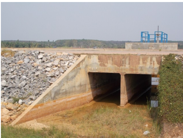
อาคารระบายน้ำด้านหน้าโครงการ
