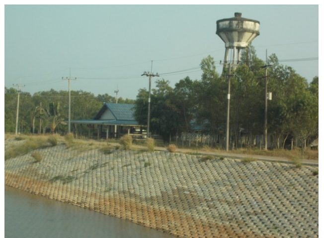
เตรียมปรับปรุงระบบประปา โดยใช้แหล่งน้ำดิบจากโครงการ
