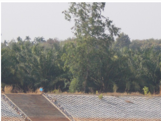
บันไดคอนกรีต / ปูอิฐบล็อกคอนกรีตด้านหน้าโครงการ
