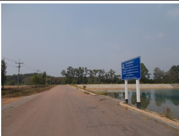
ถนนคอนกรีต (คลส.) ด้านหน้าโครงการ
