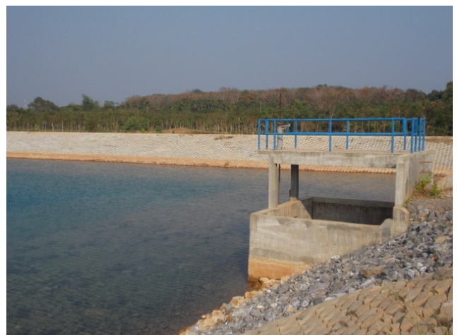
อาคารบังคับน้ำด้านหน้าโครงการ
