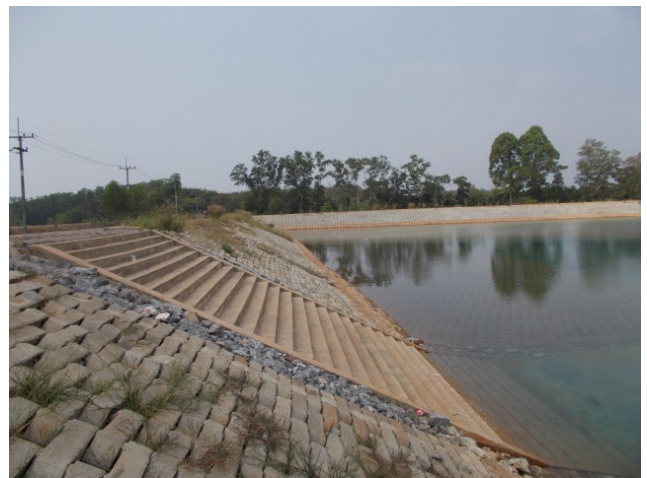
บันไดคอนกรีตเสริมเหล็ก(คสล.)
