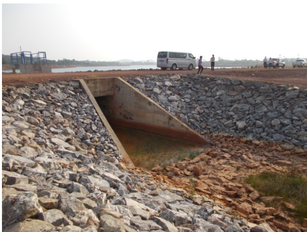
อาคารระบายน้ำด้านหลังโครงการ
