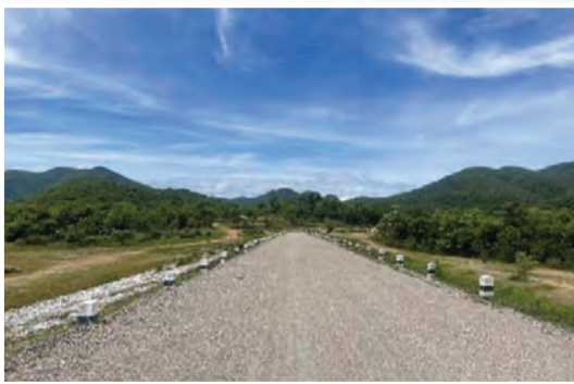
งานเสริมหินคลุกบริเวณสันเขื่อน Crushed stone reinforcement on dam crests
