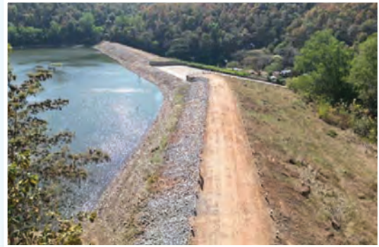
งานป้องกันการกัดเซาะบริเวณลาดเหนือน้ำและลาดท้ายน้ำ Erosion prevention in upstream and downstream slopes
