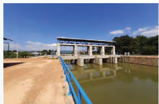
งานลูกรังเกลี่ยบดอัดแน่นบริเวณคันดินห้วย Compaction of gravel around embankment
