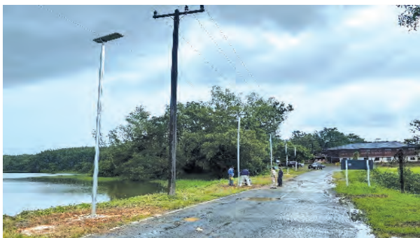
งานติดตั้งไฟส่องสว่างโซล่าเซลล์
