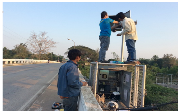
ภาพที่ ๒ การบำรุงรักษาระบบตรวจวัดสภาพน้ำทางไกล อัตโนมัติ (Telemetry)
