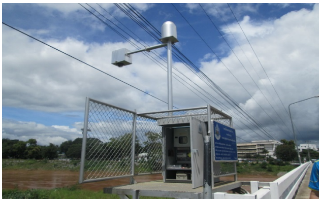
ภาพที่ ๑ การบำรุงรักษาระบบตรวจวัดสภาพน้ำทางไกล อัตโนมัติ (Telemetry)
