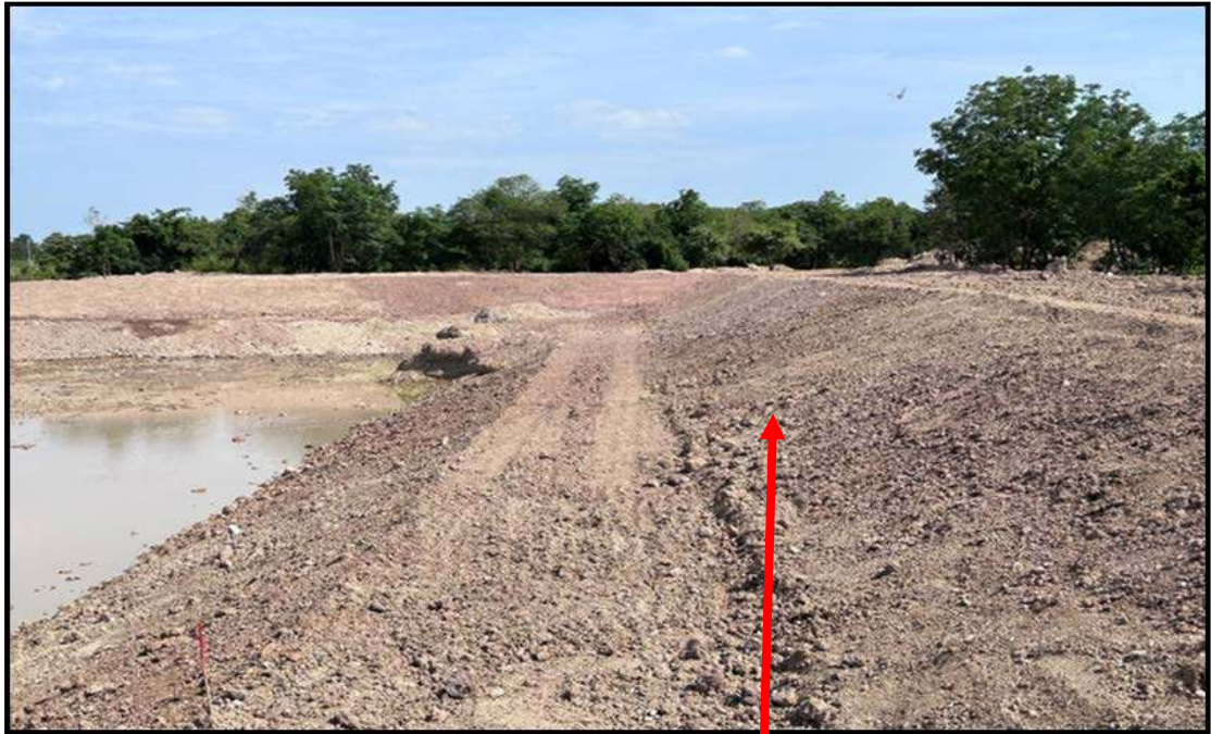
ปรับแต่ง Slope ด้านในให้มีความเสมอ เรียบร้อย และสวยงาม
