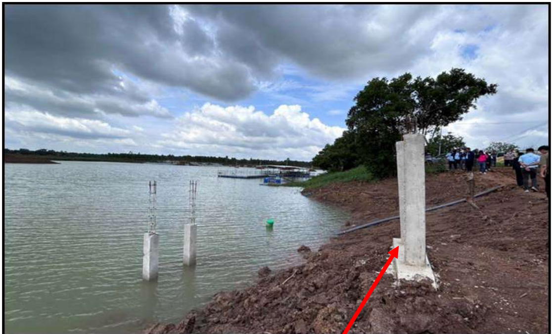
ซ่อมเสาต่อหม้อของอาคารสูบน้ำให้ตรง
