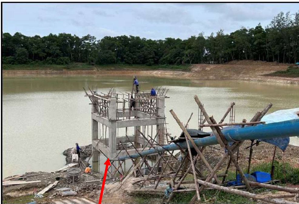
บริเวณอาคารสูบน้ำเพิ่ม staff gate เพื่อให้กลุ่มผู้ใช้น้ำรู้ปริมาณน้ำคงเหลือในสระ
