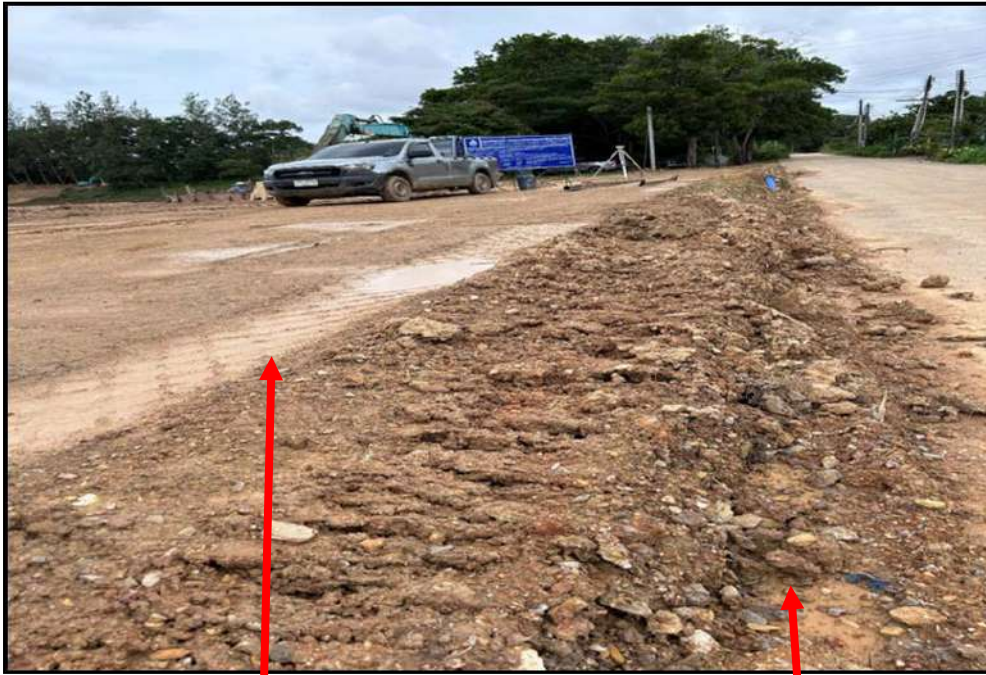
ปรับเกลี่ยดิน และทดสอบความหนาแน่นของดิน
