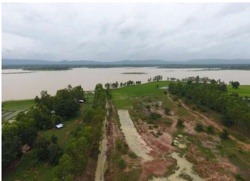
รูปที่ 1.1 อ่างเก็บน้ำลำพระยงตอนบนและคูคันดินคูน้ำคันดินส่งน้ำเชื่อมห้วยมะโน และห้วยสายนา
