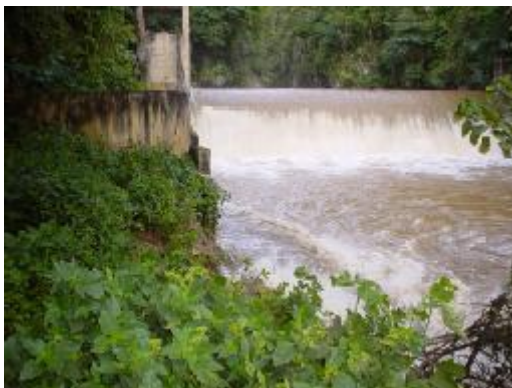
ฝายทดน้ำ โครงการไฟฟ้าพลังน้ำแม่ฮ่องสอน
