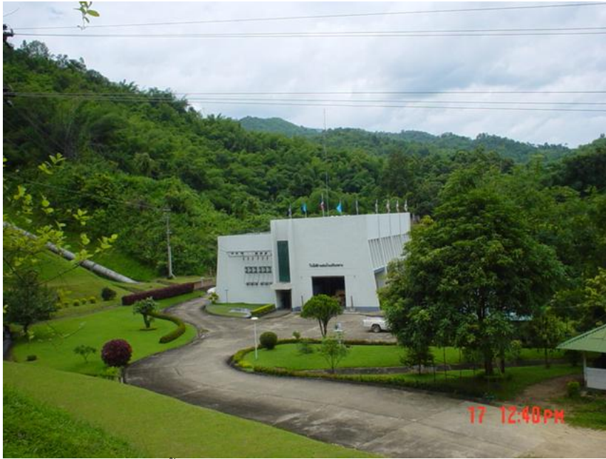
โครงการไฟฟ้าพลังน้ำขนาดเล็ก โครงการแม่กิมหลวง อำเภอแม่เมาะ จังหวัดเชียงใหม่
