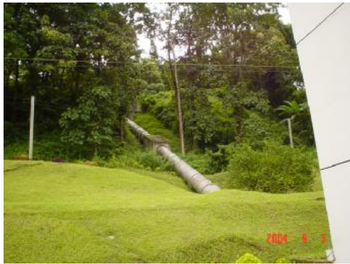
ท่อส่งน้ำ โครงการไฟฟ้าพลังน้ำแม่ฮ่องสอน
