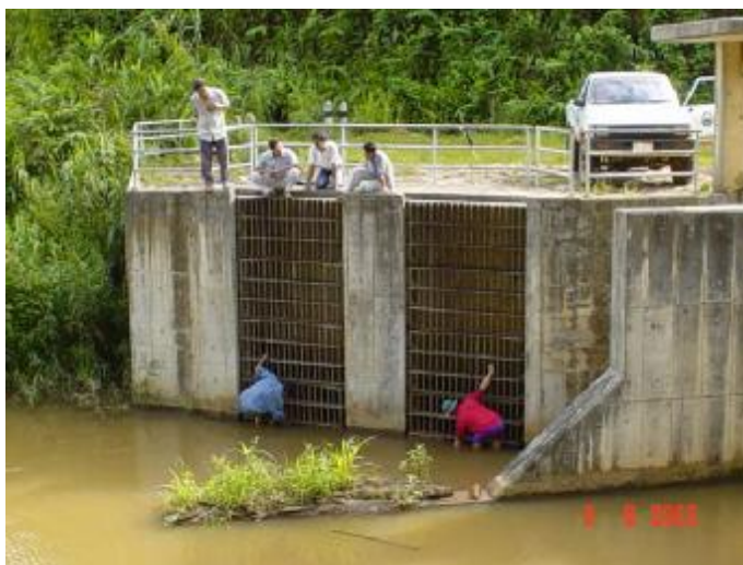
อาคารรับน้ำ โครงการไฟฟ้าพลังน้ำห้วยน้ำขุ่น
