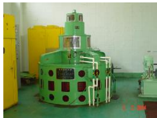
เครื่องกังหันน้ำและเครื่องกำเนิดไฟฟ้าแบบคาปาแล
