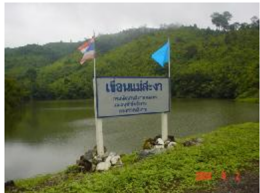
อ่างเก็บน้ำ โครงการไฟฟ้าพลังน้ำแม่สะงา
