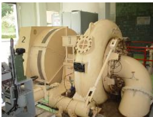
เครื่องกังหันน้ำและเครื่องกำเนิดไฟฟ้าแบบฟรานซิส
