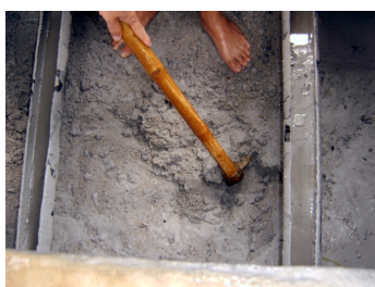
รูปที่ 67 การใช้จอบคุ้ยหน้าทรายกรอง
