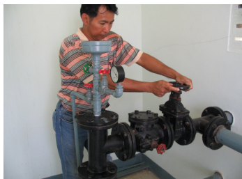
รูปที่ 60 ปิดประตูน้ำด้านท่อจ่ายน้ำของเครื่องสูบน้ำดี
