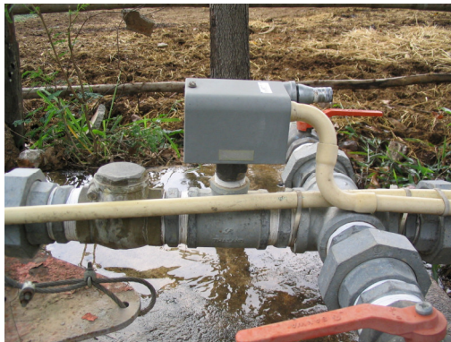
รูปที่ 20 การติดตั้งสวิตช์ใบพายที่ปากบ่อบาดาล
