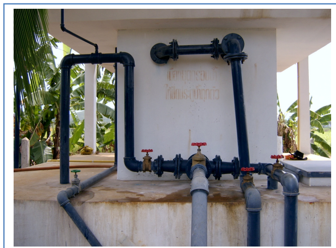
รูปที่ 24 ประตูน้ำในระบบผลิต
