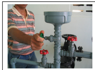
รูปที่ 39 การเติมน้ำเข้าเครื่องสูบน้ำโดยใช้น้ำจากห้องสูง
