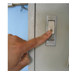
รูปที่ 43 ปุ่มปิดประตูตู้ควบคุมเครื่องสูบน้ำดี
