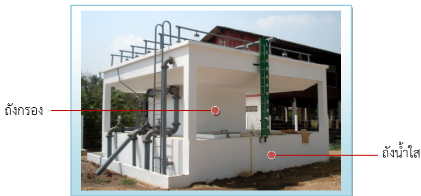
รูปที่ 22 ถังกรองและถังน้ำใส
