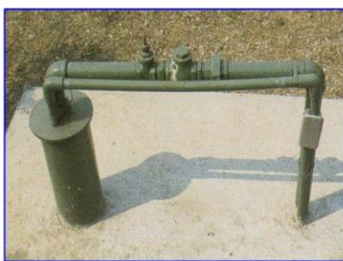
บ่อน้ำบาดาลและเครื่องสูบน้ำดิบ
