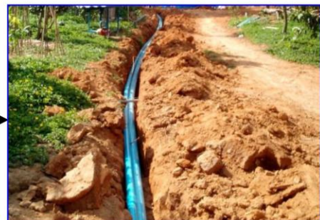
ท่อจ่ายน้ำ
