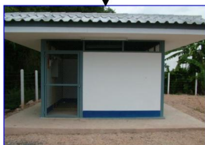
โรงเก็บ/จ่ายสารเคมี และตู้ควบคุมควบคุม
