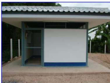
โรงเก็บ/จ่ายสารเคมี และตู้ควบคุม
