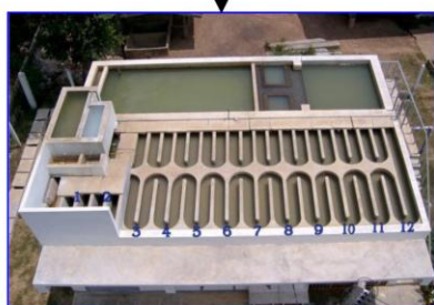
ถังสร้างตะกอน / ถังรวมตะกอน / ถังตกตะกอน / ถังกรอง
