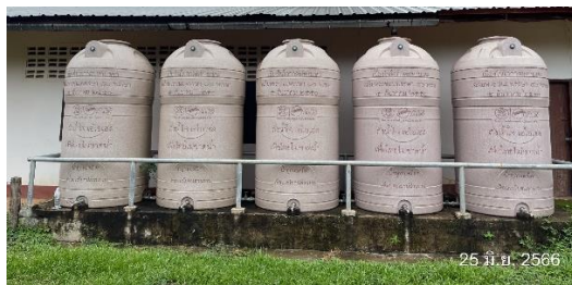
รูปตัวอย่างการยกพื้นเพื่อตั้งภาชนะบรรจุน้ำฝน
