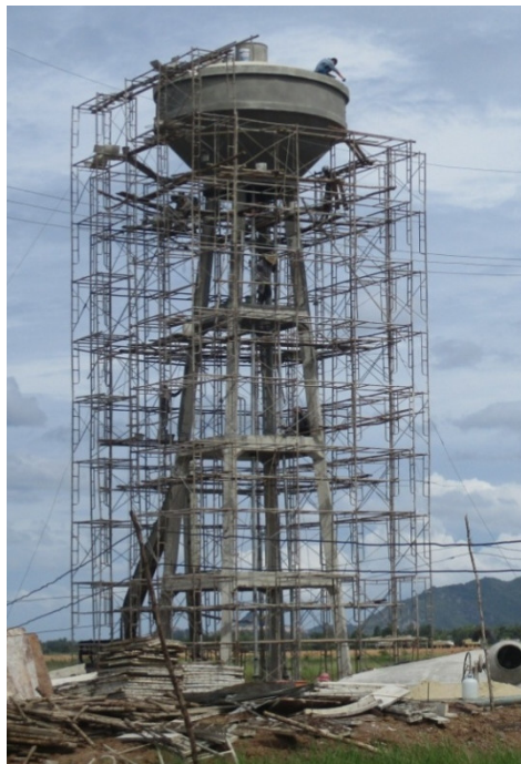
รูปที่ 66 งานประกอบนั่งร้านก่อสร้างหอดังสูง
