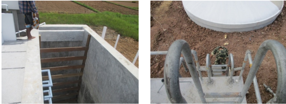
รูปที่ 75 งานติดตั้งบันได ขึ้น-ลง ถังกรองน้ำผิวดิน
