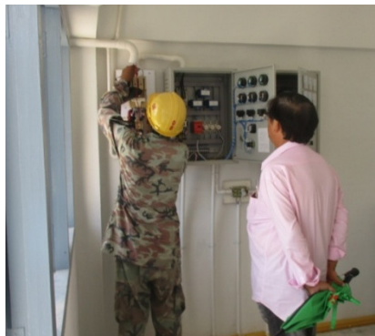
รูปที่ 44 ติดตั้งอุปกรณ์ไฟฟ้าที่แผงสวิตช์ในโรงสูบน้ำ
