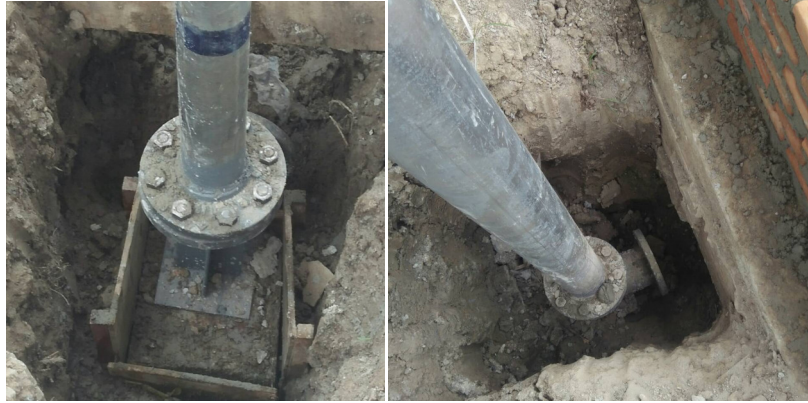
รูปที่ 79 งานท่อจ่ายน้ำหอดึงสูงและข้องอตีเปิด
