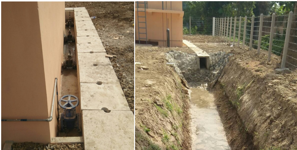
รูปที่ 39 ทางระบายน้ำทิ้ง
