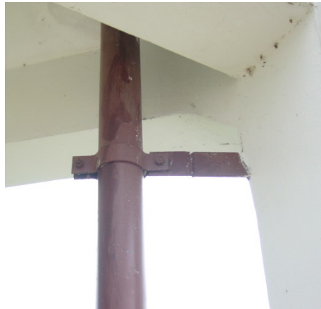
รูปที่ 68 งานฝังเหล็กหางปลา ในคานทุกชั้น สำหรับยึดท่อขึ้นหอดังสูง
