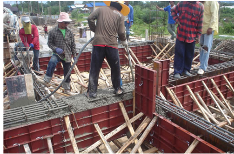
รูปที่ 19 การเทและต้อนกระทุ้งให้คอนกรีตด้วยเครื่องสั่น (Vibrator)
