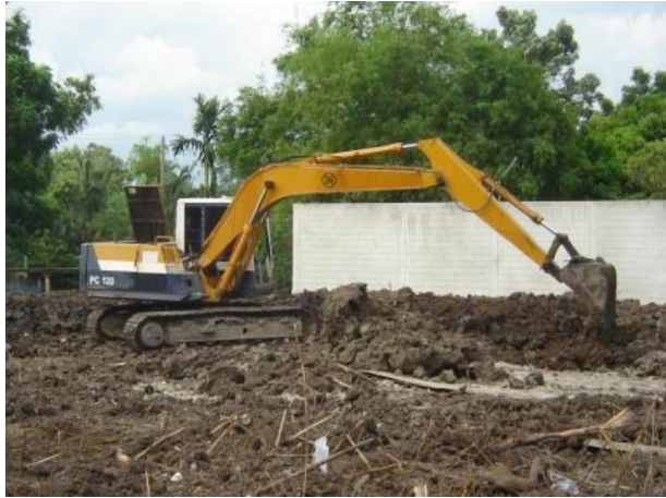
รูปที่ 2 การปรับพื้นที่ บริเวณที่ทำการก่อสร้าง
