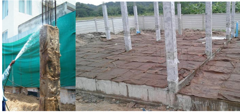
รูปที่ 20 การบ่มคอนกรีตโดยใช้น้ำฉีดพ่นทับบนกระสอบ
