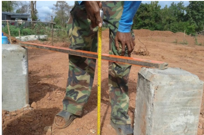
รูปที่ 7 การตรวจสอบค่าระดับหัวเสาเข็มงานฐานราก
