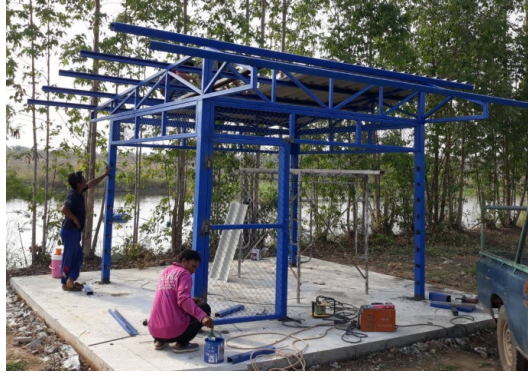
รูปที่ 40 งานทาสีโครงเหล็กโรงสูบน้ำ
