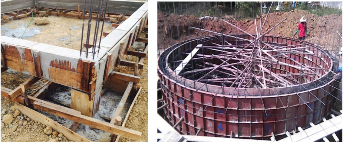
รูปที่ 12 แบบหล่อคอนกรีตทำด้วยไม้และโลหะ
