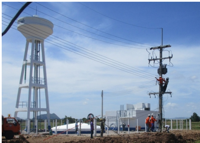
รูปที่ 42 งานระบบไฟฟ้าภายนอก
