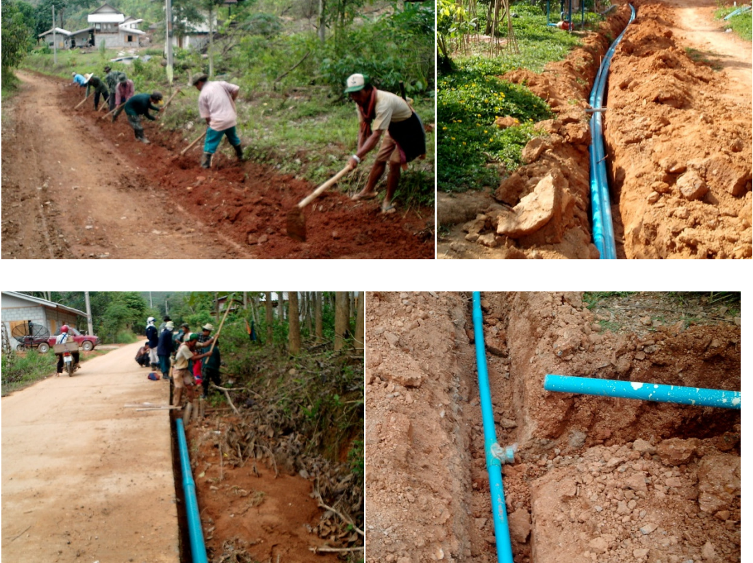
รูปที่ 38 การขุดและการวางแนวท่อจ่ายน้ำ
