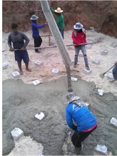
รูปที่ 18 การใช้รางเทคอนกรีตหยาบฐานรากถึงน้ำใส เพื่อป้องกันการแยกตัวของคอนกรีต (ความสูงไม่เกิน 1.50 ม.)
