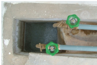
รูปที่ 76 จุดที่ผสมสารละลายสารส้ม และปูนขาว ไฮดรอลิกจัมป์ (HYDRAULIC JUMP)
