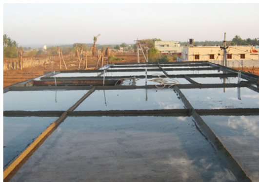
รูปที่ 21 การบ่มคอนกรีตโดยใช้น้ำขัง
