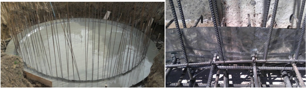
รูปที่ 69 งานเทคอนกรีตฐานรากโครงสร้างถึงเก็บน้ำติดตั้งแผ่นสังกะสีกันซึมช่วงรอยต่อคอนกรีต
