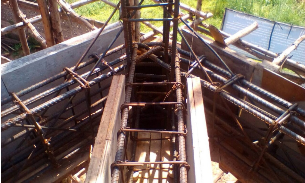
รูปที่ 67 งานเข้าแบบ ผูกเหล็ก เสาคาน หอดังสูง
