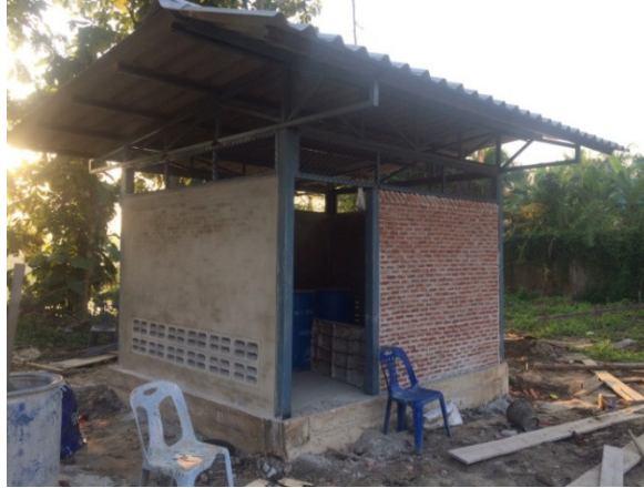
รูปที่ 32 งานก่ออิฐฉาบปูนโรงสูบน้ำ
