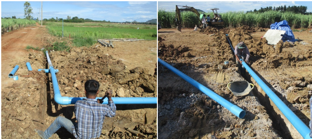
รูปที่ 80 งานวางท่อจ่ายน้ำ
