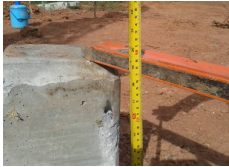
รูปที่ 63 ตรวจสอบระยะตัดหัวเสาเข็ม โดยหลังจากตัดหัวเสาเข็มแล้ว ต้องมีเหล็ก DOWEL BAR ตามที่กำหนด
