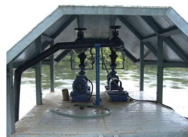
การติดตั้งเครื่องสูบน้ำในโรงคลุม
