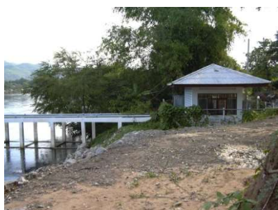
โรงสูบน้ำตั้งอยู่บนตลิ่ง
