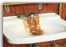
รูปที่ 2-10 ปัญหาที่เกิดจากน้ำมีสารละลายเหล็ก
