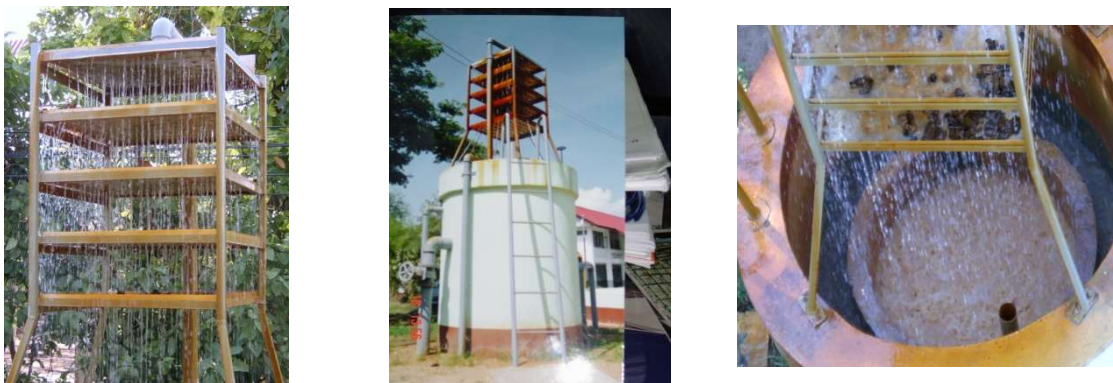
รูปที่ 2-9 Tray Aerator พร้อมถังกรอง
