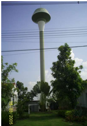
หอถังสูงเหล็กทรงกลมแป้น
