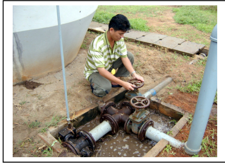
รูปที่ 65 เปิดประตูระบายน้ำทิ้งจากพื้นถังกรอง (ประตุน้ำหมายเลข 4)
