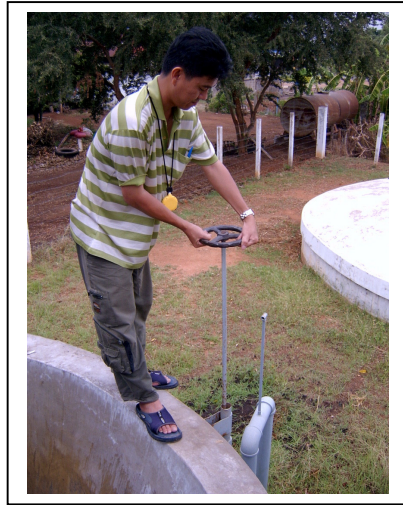
รูปที่ 68 เปิดประตูน้ำจากท่อถังสูงเข้าถังกรอง (ประตูน้ำหมายเลข 2)
