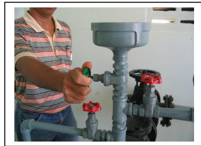
รูปที่ 41 การเติมน้ำเข้าเครื่องสูบน้ำโดยใช้น้ำจากท่อถังสูง
