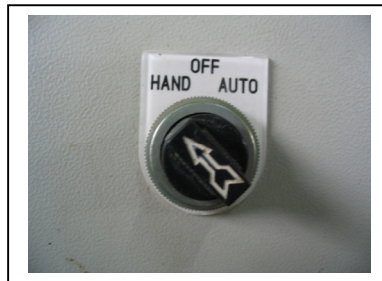
รูปที่ 47 สวิตช์ลูกศรที่ตำแหน่ง “HAND”
