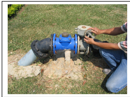
รูปที่ 63 ปิดประตูน้ำจ่ายน้ำประปา (ประตูน้ำหมายเลข 1)
