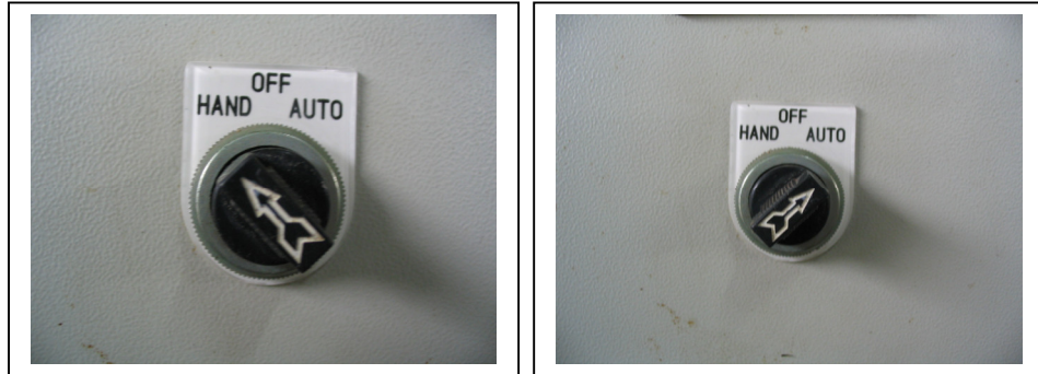
รูปที่ 55 บิดสวิตช์ลูกศรไปที่ตำแหน่ง “HAND” หรือ “AUTO”
