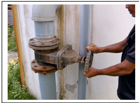
รูปที่ 66 เปิดประตูน้ำระบายตะกอนในถังกรอง (ประตุน้ำหมายเลข 5)
