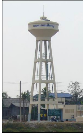
รูปที่ 53 หอถังสูง
