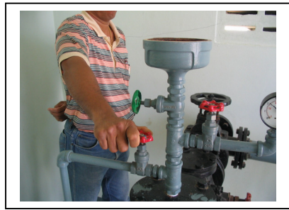
รูปที่ 41 การเติมน้ำเข้าเครื่องสูบน้ำโดยใช้น้ำจากท่อถังสูง
