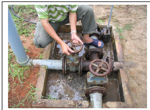
รูปที่ 58 เปิดประตูน้ำลงถังน้ำใส (ประตูน้ำหมายเลข 3)
