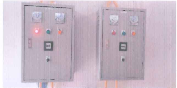
ภาพหลังดำเนินงาน
