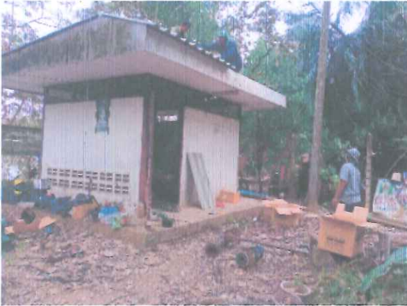
ภาพก่อนดำเนินงาน
