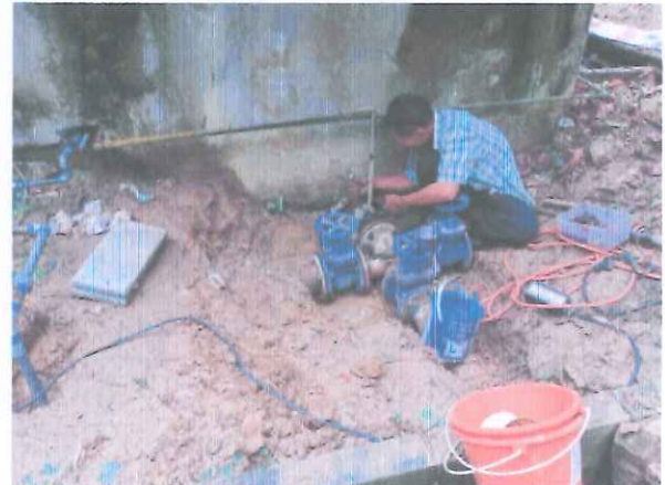
ภาพหลังดำเนินงาน
