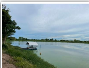
โครงการก่อสร้างระบบกระจายน้ำ ด้วยพลังงานแสงอาทิตย์หนองบัว
