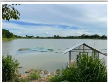
โครงการก่อสร้างระบบกระจายน้ำ ด้วยพลังงานแสงอาทิตย์หนองไผ่ล้อม
