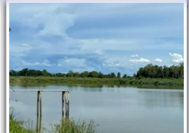
โครงการก่อสร้างระบบกระจายน้ำ ด้วยพลังงานแสงอาทิตย์บึงถึงสาธารณประโยชน์
