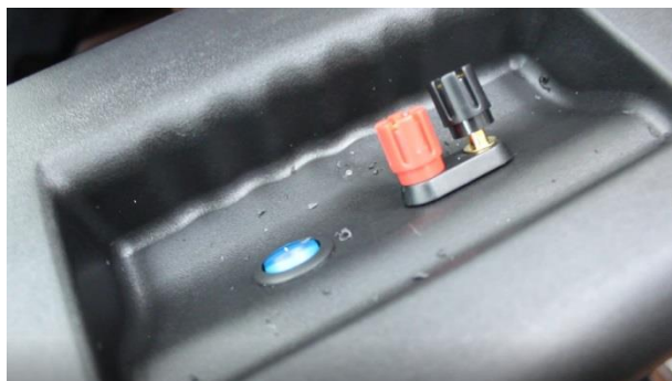
ภาพที่๑๐ การติดตั้งสวิตช์และหัวรับโซลาร์เซลล์
