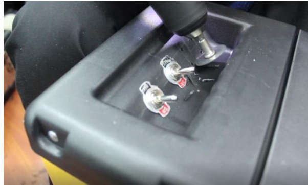
ภาพที่๑๑ การติดตั้งสวิตช์เปิด-ปิด เมนไฟของกล่องและสวิตช์ ชาร์จ AC ๒๒๐
