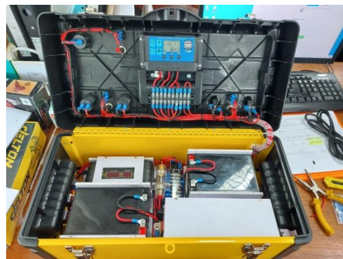
ภาพที่๑๖ การเดินสายไฟและต่อเชื่อมสายไฟกับตัวอุปกรณ์
