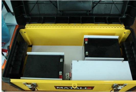
ภาพที่๘ การติดตั้งแบตเตอรี่ ๒ ลูก
